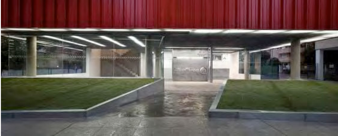
Fig. 08: Fotografía Cibercentro Macarena. Fotógrafo: Fernando Alda. 2010.
